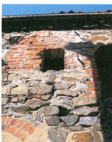
Foto 6. Pavone Canavese. Muratura mista con tamponamento in cemento (Foto scattata dal gruppo)
