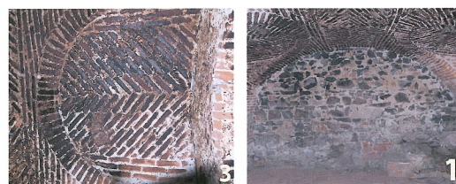
1. Parete Nord, incontro tra le volte a botte che generano le unghie 2. Parete Est, unghia 3. Soffitto, disposizione mattoni in corrispondenza dell'unghia
