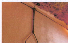
Impianto elettrico con tubi a vista
