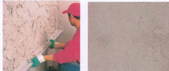
1) Posa in opera intonaco macroporoso, 2) Risultato
