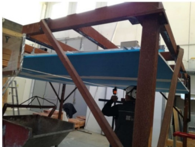
Fotografia della superficie d'intradosso dell'oggetto
