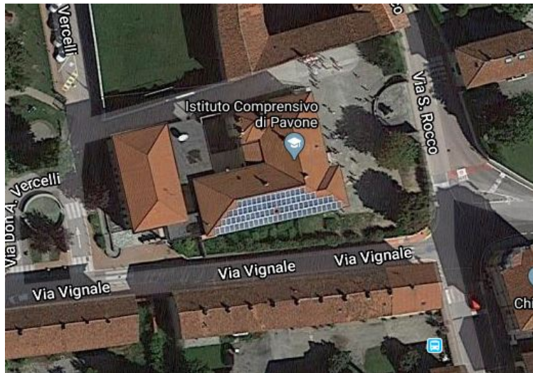
Vista ortofoto del complesso scolastico oggetto di intervento edilizio
