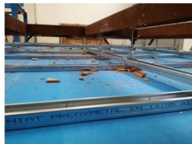
Fotografia della superficie d'estradosso dell'oggetto dopo l'urto n. 7, una volta rimosse le macerie degli elementi di caduta
