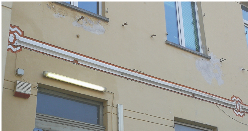
La fascia marca piano esistente
